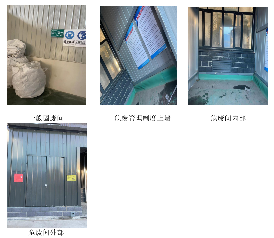
图3-2 固废暂存场所
